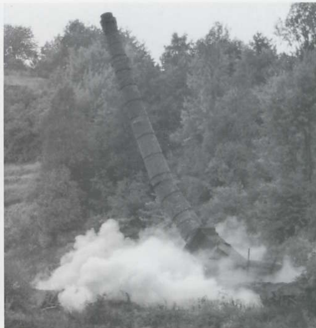
Schornsteinsprengung an der alten Ziegelei Hesse an der B 27.
