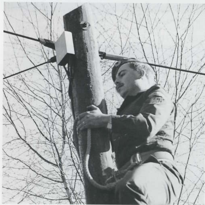
POM Eberhardt beim Anschluß eines Übergabepunktes der Deutschen Bundespost im Lager Hundstadt 1987.
