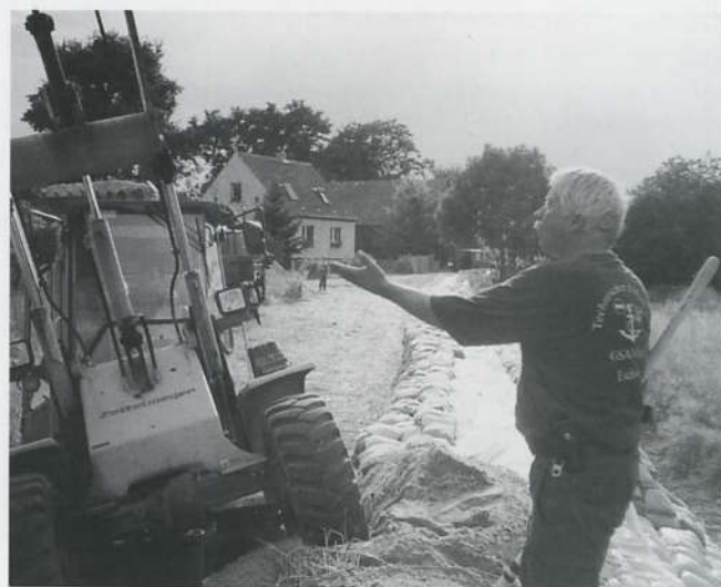
Polizeihauptmeister Günter Schröder beim Bau eines Dammes.
