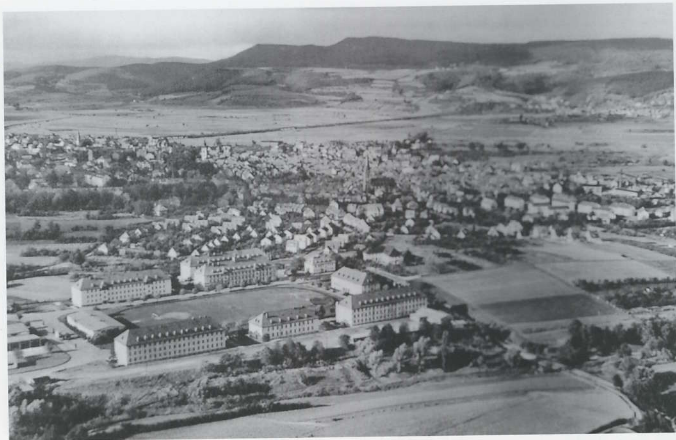
Die Hindenburgkaserne auf einer Ansichtskarte von Eschwege. Die Luftaufnahme aus dem Jahre 1969 zeigt die BGS-Unterkunft in der alten Form mit Sporthalle, Fernmeldebaracke (das Reich des PHM Jochen Witt), und den Sportplatz in der ursprünglichen Form. Im Hintergrund Grebendorf und Neuerode mit dem Meinhard, Schöne Aussicht und Hörne.
