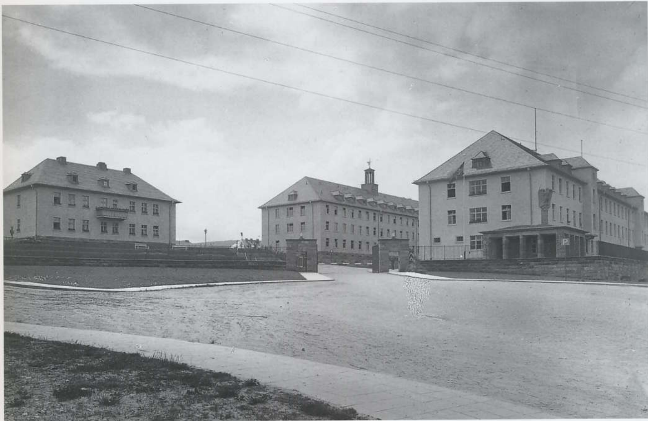
Die Hindenburgkaserne nach ihrer Fertigstellung im Jahre 1938. Im Vordergrund die alte Zaunanlage mit dem Schilderhäuschen. Rechts im Bild das Stabsgebäude mit dem Hallengang aus Sandstein, dem Sandsteinadler und den kleinen vergitterten Fenstern, hinter denen sich die Arrestzellen befanden. In diesen Räumen wurden in den 50er und 60er Jahren die vielen Überläufer der Grenztruppen der DDR untergebracht, bevor sie der zentralen Aufnahmestelle des Landes Hessen in Gießen übergeben wurden.
