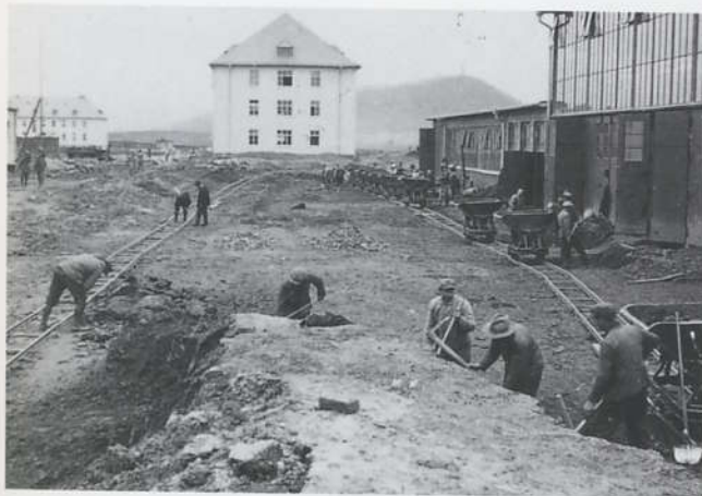
Arbeitskolonnen beim Bau der Hindenburgkaserne im Jahre 1936. Mit Loren, die man auf Schienen schob, wurden die Erdbewegungen durchgeführt. Bagger waren zu dieser Zeit noch keine Mode.
