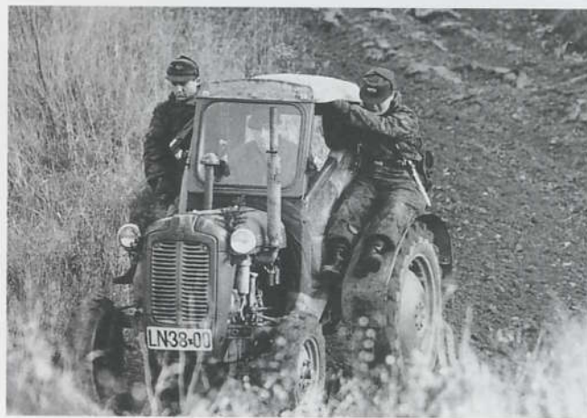
Instandsetzung des Kontrollstreifens bei Kella 1962.
